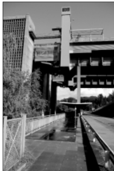
Schon von außen imposant: das Schiffshebewerk Scharnebeck
